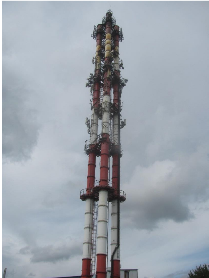
Zał. nr 1: Widok ogólny instalacji radiokomunikacyjnej.
