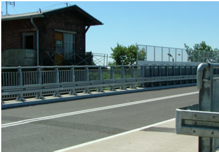
Zdj.Odbudowany wiadukt przy ul.Kołątąja w Kluczborku
