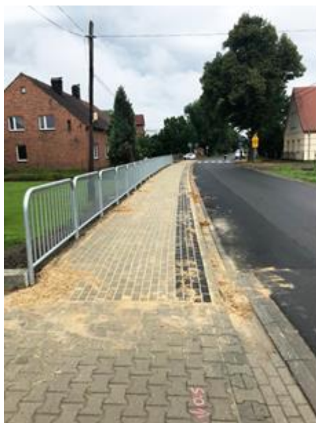
Przebudowa drogi powiatowej nr 13260 na odcinku o długości 0,484km - chodnik w miejscowości Jasienie
