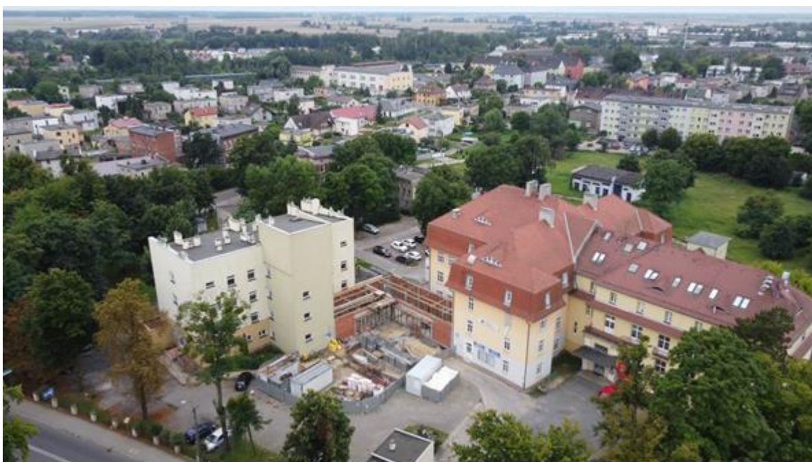
Budowa łącznika w Powiatowym Centrum Zdrowia S.A.
