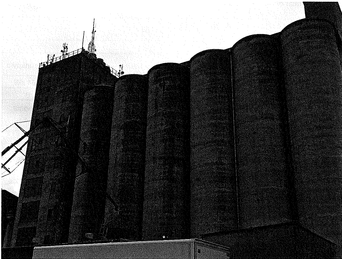
Zdjęcie 1 Badany obiekt
