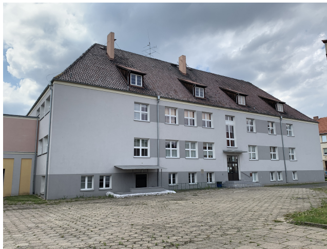
Fot. nr 1. Budynek szkoły od strony wschodniej
