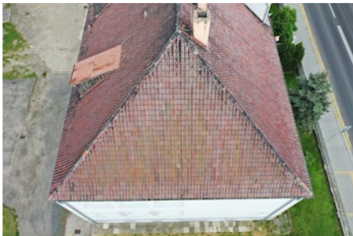
Fot. nr 4. Dach budynku szkoły od północy
