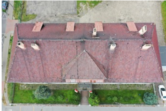
Fot. nr3 . Dach budynku szkoły od zachodu
