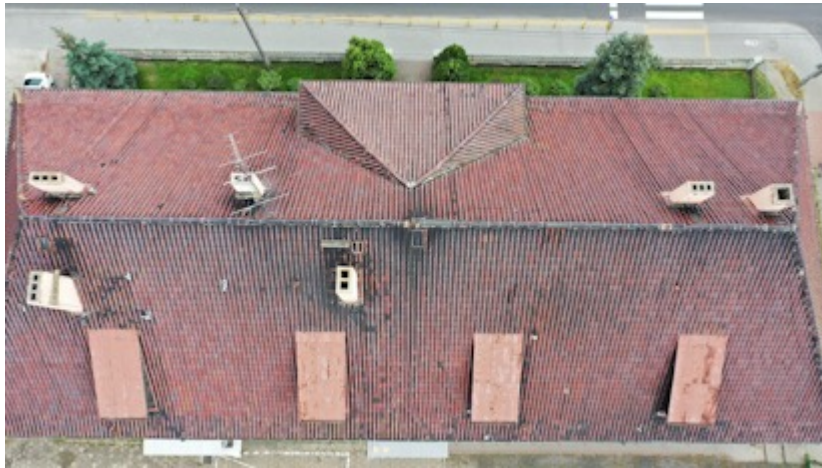
Fot. nr 2 . Dach budynku szkoły od wschodu
