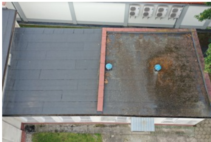
Fot. nr 11 . Dach zaplecza sali gimnastycznej
