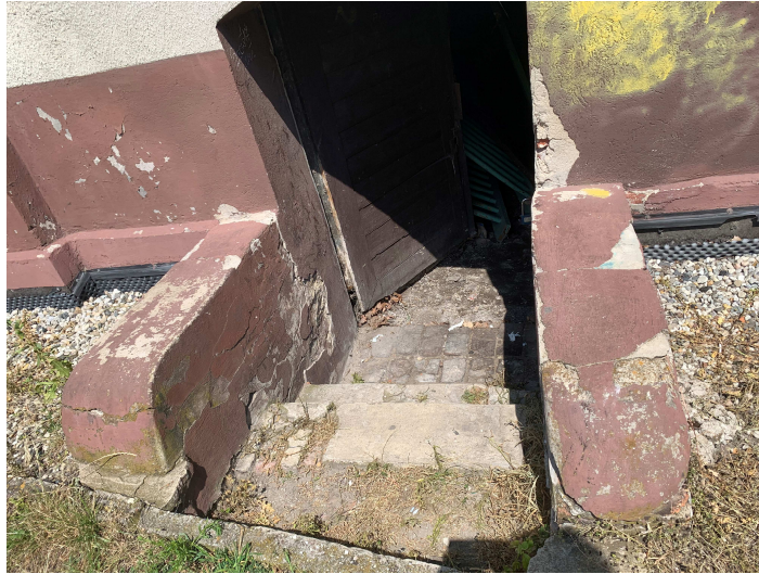
Fot. nr 6 . Budynek sali gimnastycznej – schodki od strony południowej
