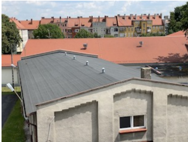
Fot. nr 9. Dach sali gimnastycznej gimnastycznej
