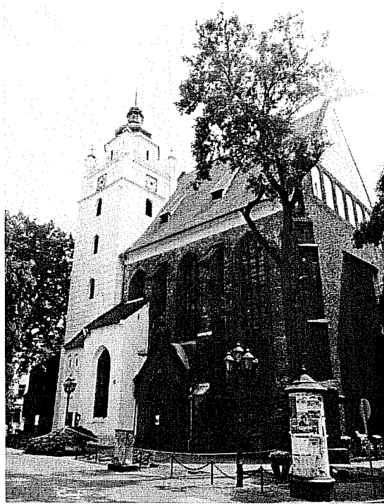
Zał. nr 1: Widok ogólny instalacji radiokomunikacyjnej.
