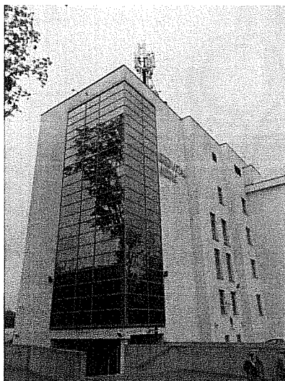
Widok obiektu wraz z zainstalowanym zespołem antenowym
